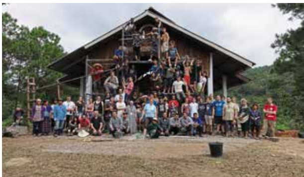
Les jeunes devant l'église St Willibrord en construction à Ban Huay Thong
